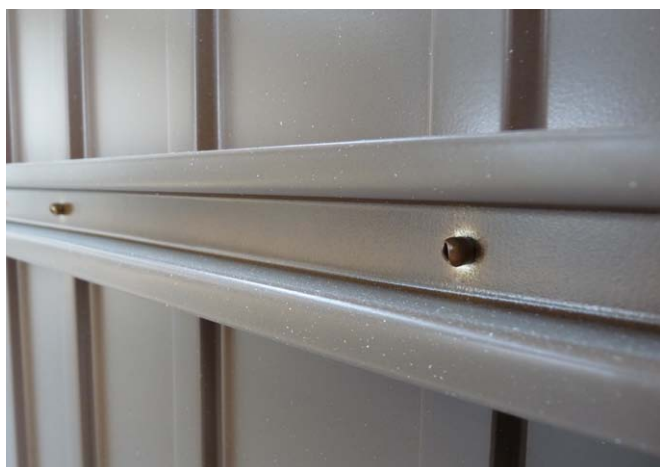
▲ Mocowanie poszycia do konstrukcji (widok od tyłu)
